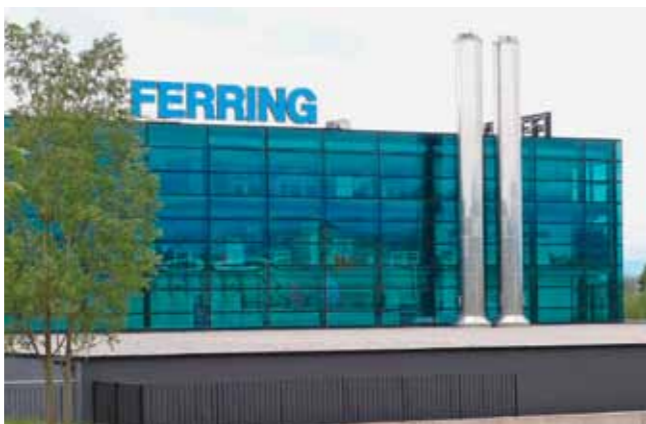
QUARTIER GÉNÉRAL Basée à Saint-Prex, l'entreprise emploie 650 employés sur un site qui sert également de lieu de production.
